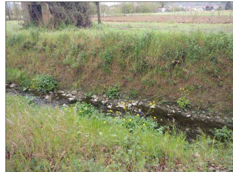
Figura 3.33 - Fosso situato presso la pk 1+200
