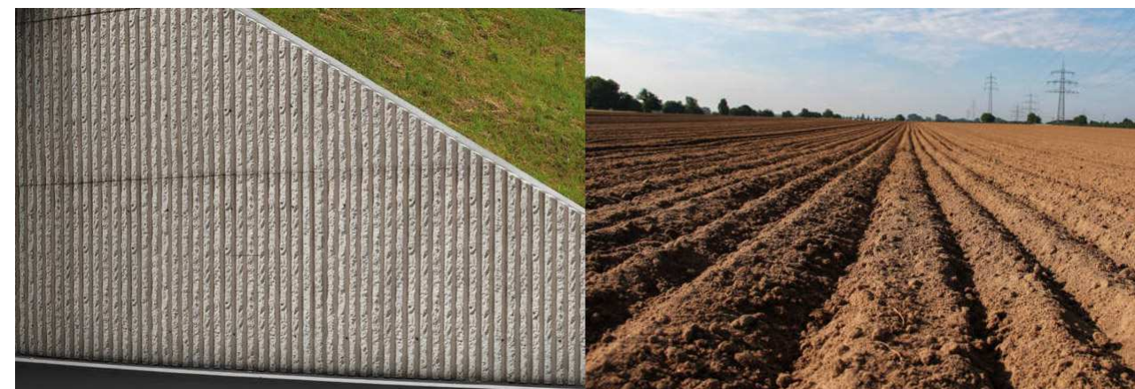
Figura 9.32 Muri in cemento facciavista trattati con matrici a motivo rigato a spacco irregolare.
