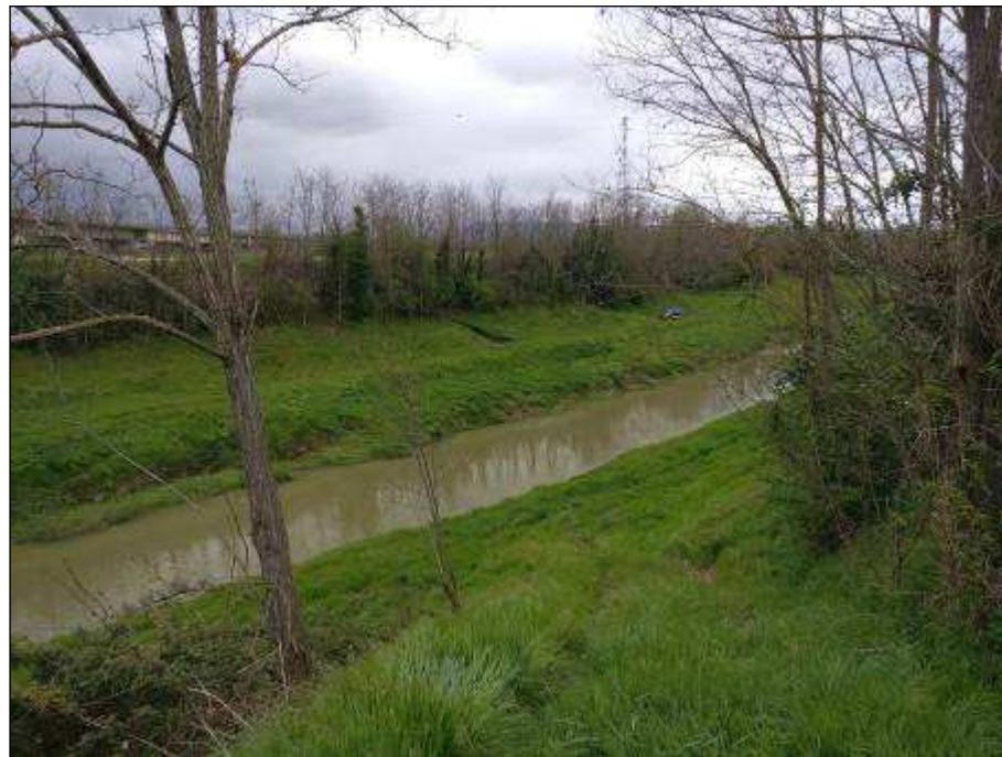
Figura 3.27 - Canale Maestro della Chiana attraversato tra le pk. 2+925-3+050 (vista verso sud)
