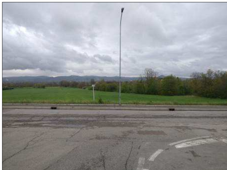
Figura 3.34 - Area di conoide situata presso la località Madonna di Mezza Strada, presso la rotonda del Ramo D
