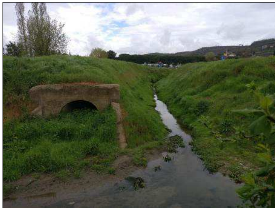
Figura 3.31 - Canale artificiale situato presso l'attraversamento con la Strada comunale Ristradella
