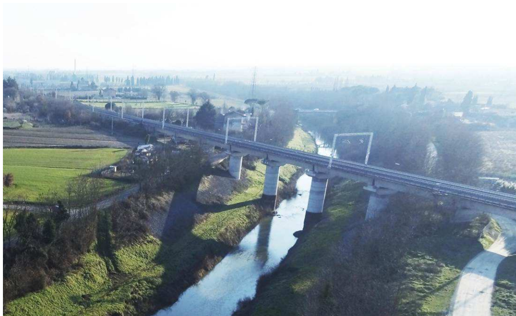
Figura 9.8 Immagine del sovrappasso esistente linea AV sul Canale Maestro della Chiana.
