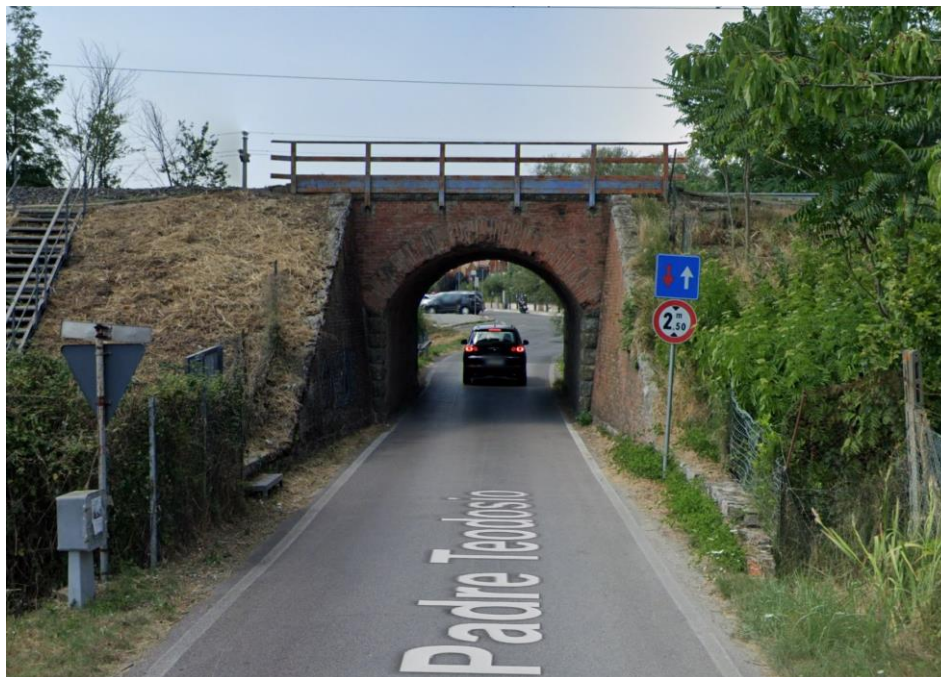
Figura 6.13 – Sottopasso ferroviario lungo Via Padre Teodosio
