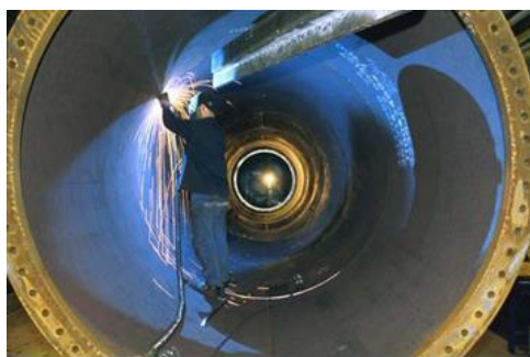
Figura 17: interno di una torre
