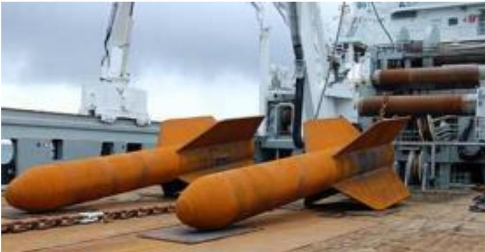
Figura 5-9 – Illustrazione di pali a siluro
