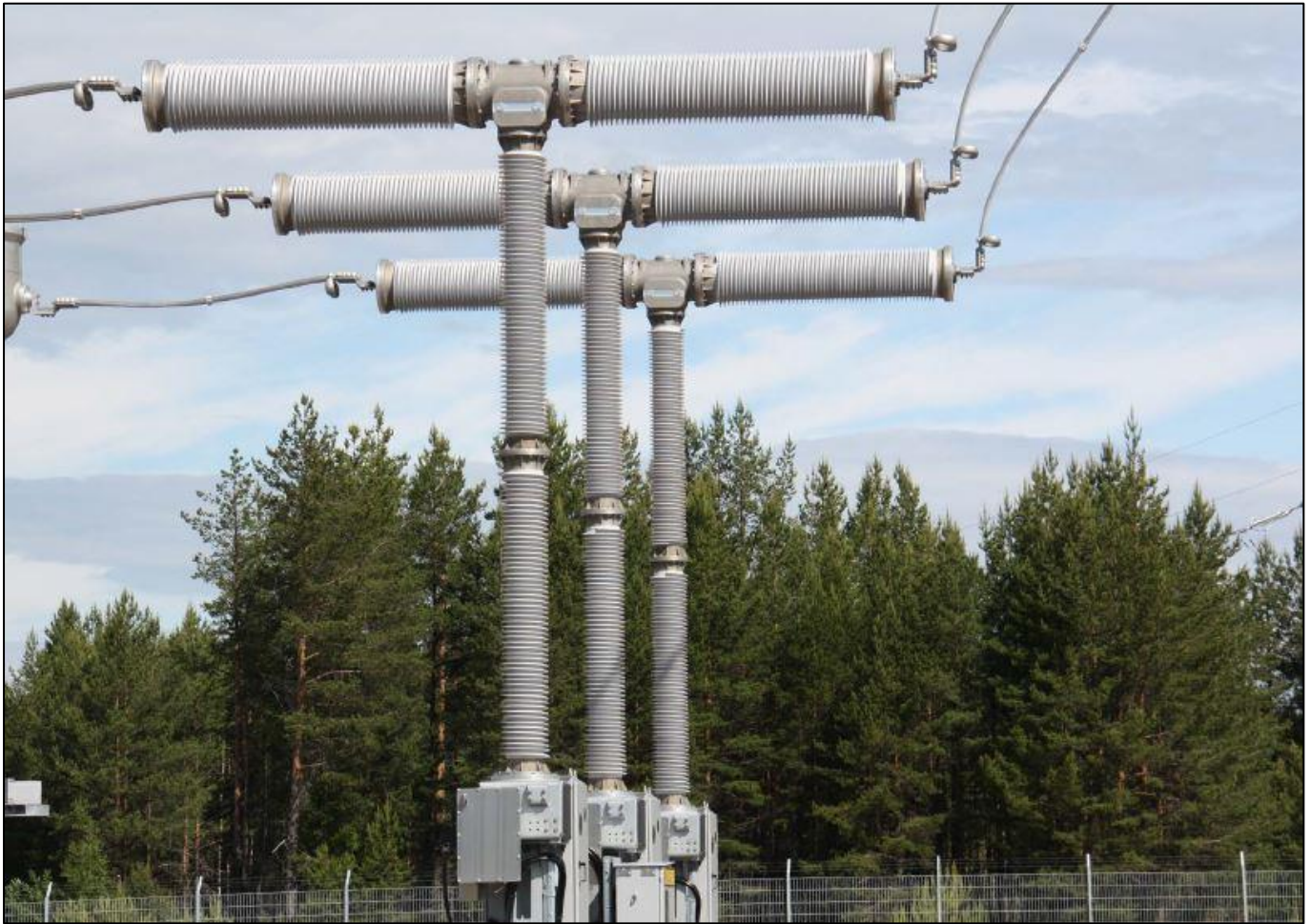
Figura 29 - interruttore 420kV (fonte Siemens)
