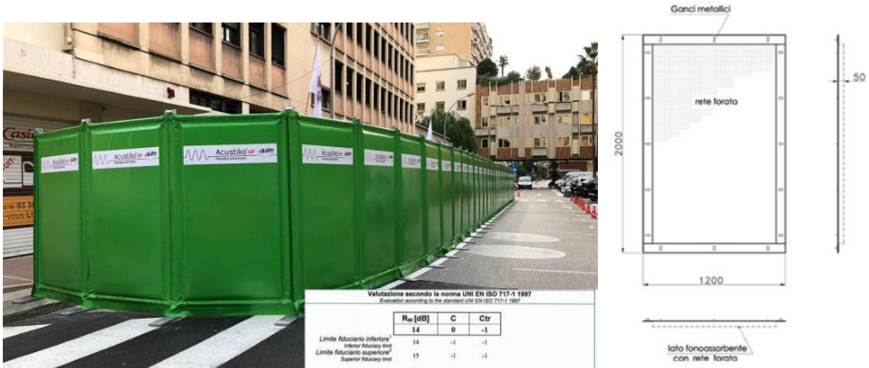
Fig. 21: Caratteristiche tecniche e dati di abbattimento della barriera antirumore temporanea di cantiere
