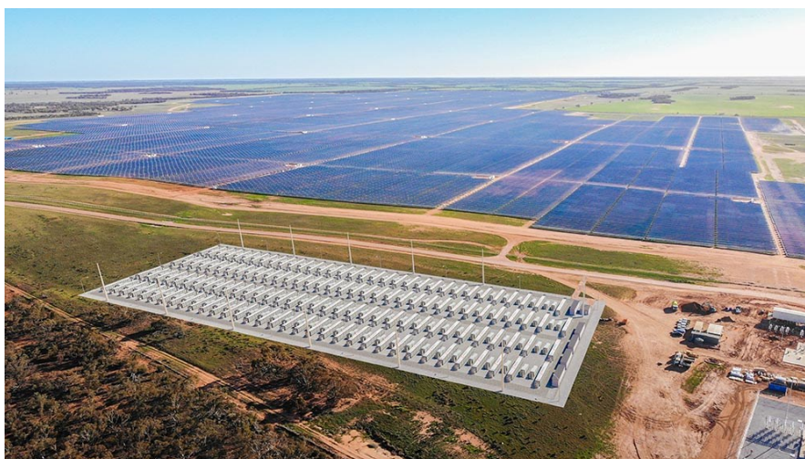
Immagine esempio di impianto BESS
