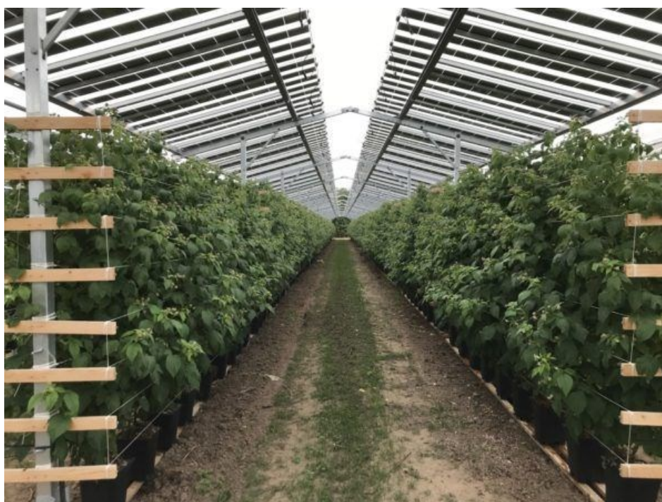
Esempio di impianto agro-fotovoltaico
