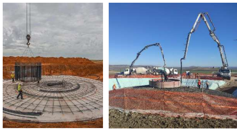
Figura 93 - Fondazione tipo aerogeneratore
