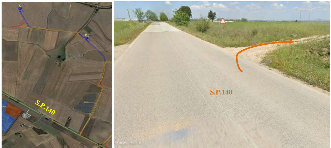
Figura 62 - Immagini della S.P.140 in prossimità dell'accesso per gli aerogeneratori S01 e S11
