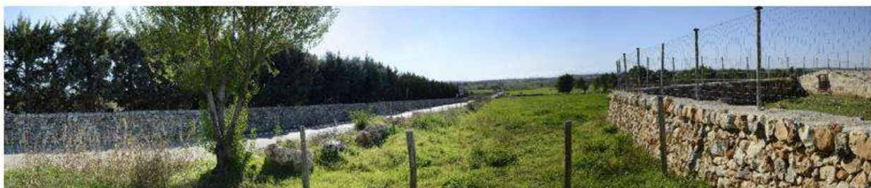
Stato di fatto del F65
