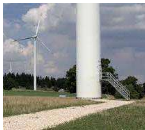
Figura 94- Immagini tipo di alcune fasi di lavorazione della Fondazione degli aerogeneratori
