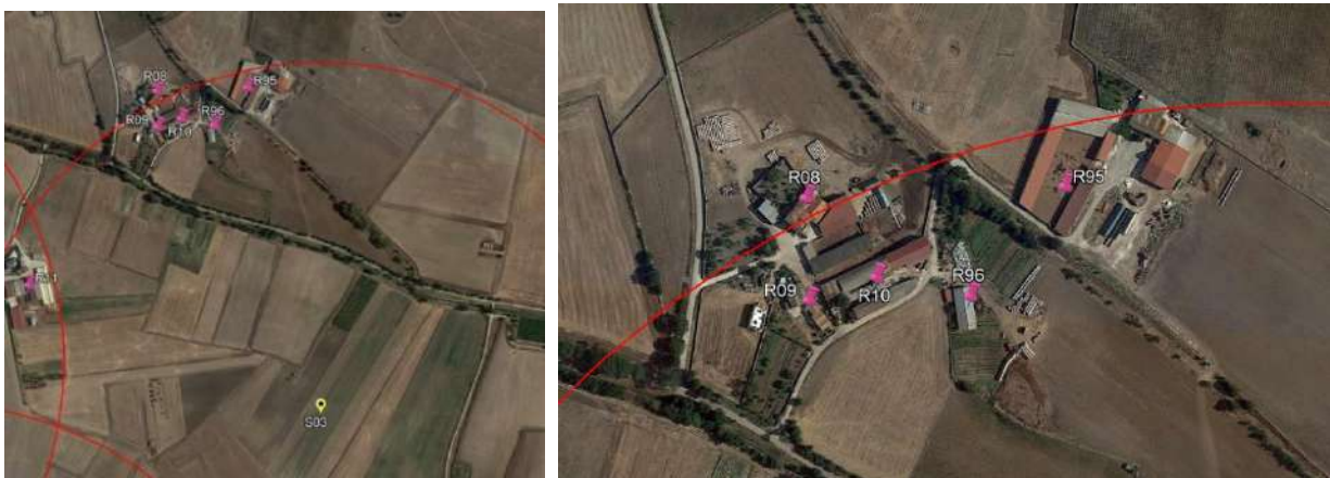
Figura 183 Disposizione dei ricettori R-08, R-09, R-10, R-95 e R-96 rispetto l'aerogeneratore S03 e inquadramento di dettaglio
