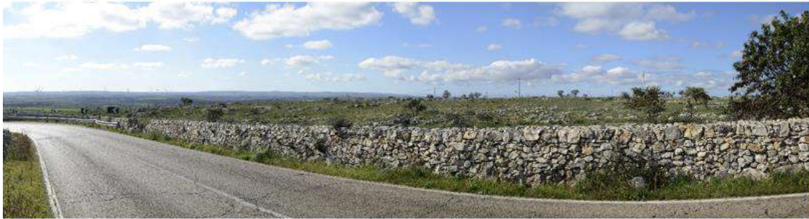
Stato di fatto del F71
