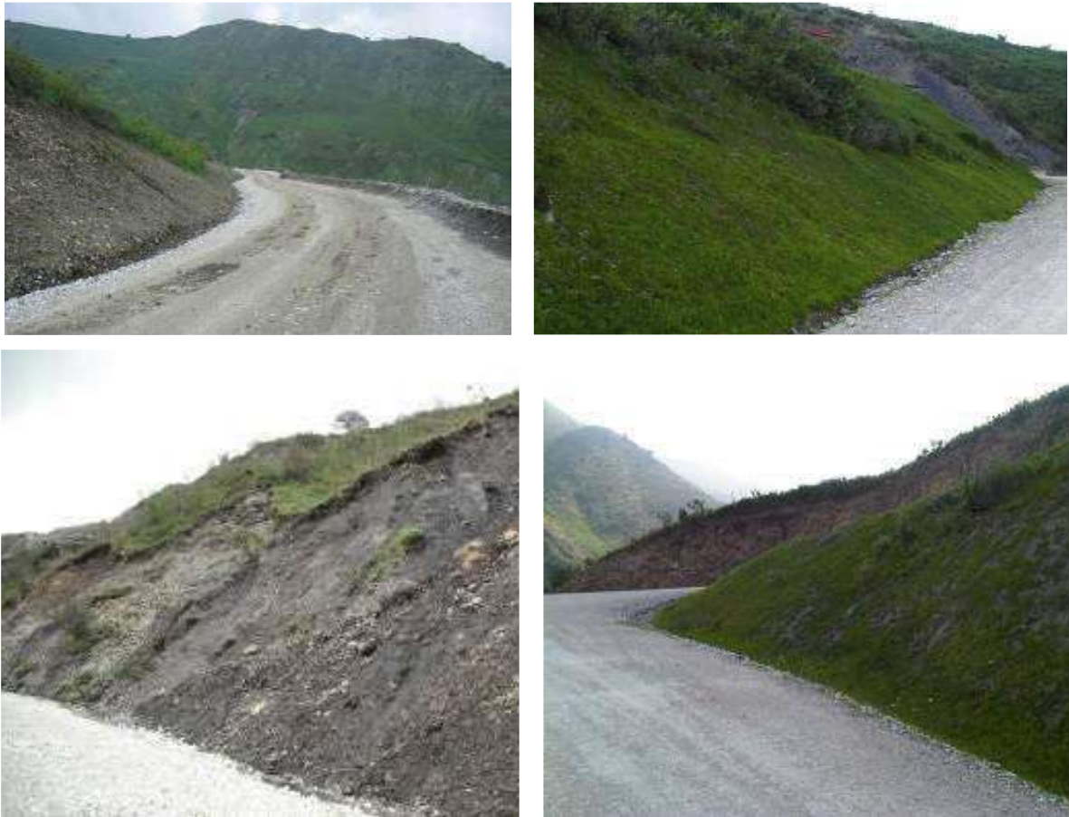
Figura 104 - Esempi di inerbimento post-operam delle scarpate oggetto di intervento, ove e se necessari
