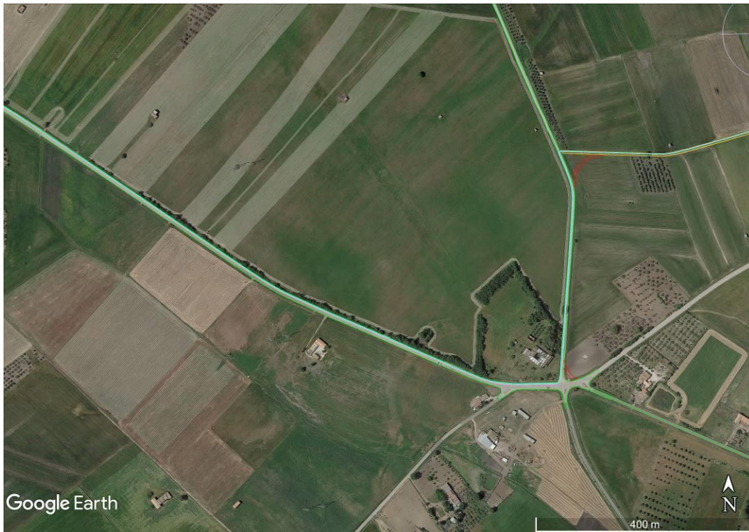
Fig. 18. Area del cavidotto sulla SP 140 (Fonte immagine: GoogleEarth 05/2013).
