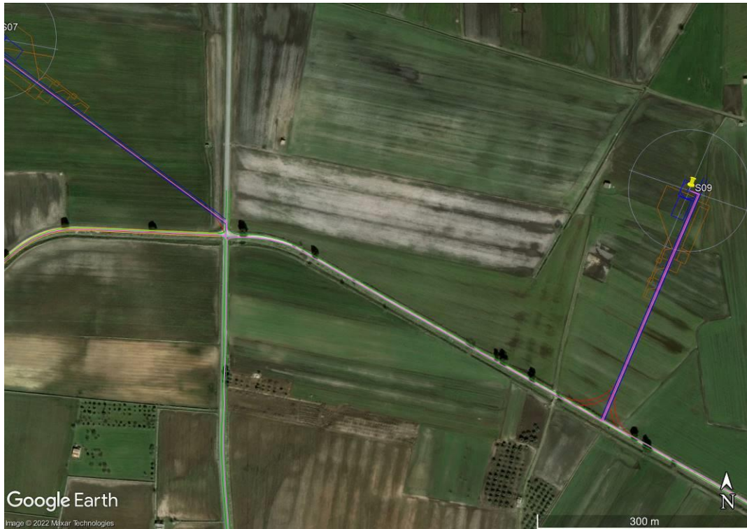
Fig. 21. Cavidotto S09-S07 (Fonte immagine: GoogleEarth 03/2011).
