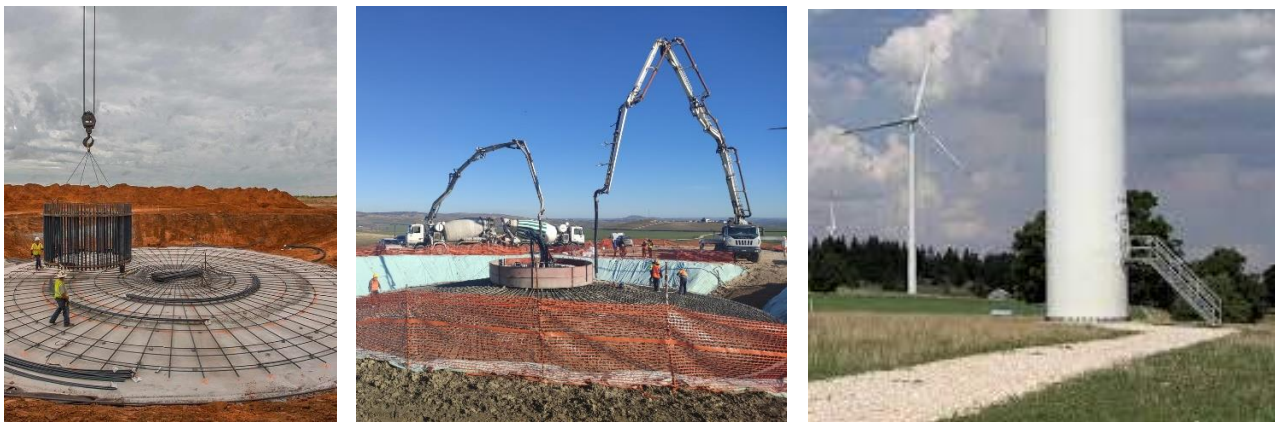
Figura 8 - Immagini tipo di alcune fasi di lavorazione della Fondazione degli aerogeneratori
