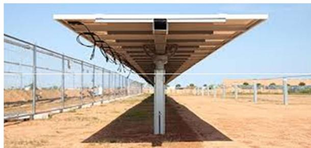
*Figura 1 – Particolare struttura di supporto pannelli*
