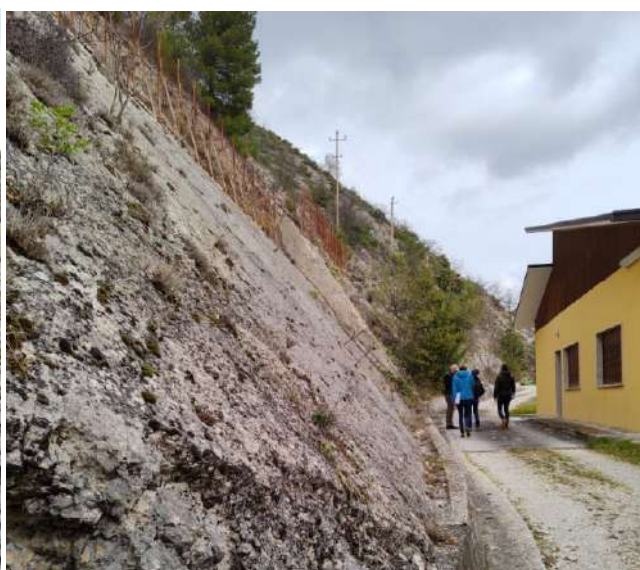
Vista dei medesimi calcari all'esterno presso la "partenza" della tubazione; si notano le superfici di strato che caratterizzano la inclinazione del versante stesso
