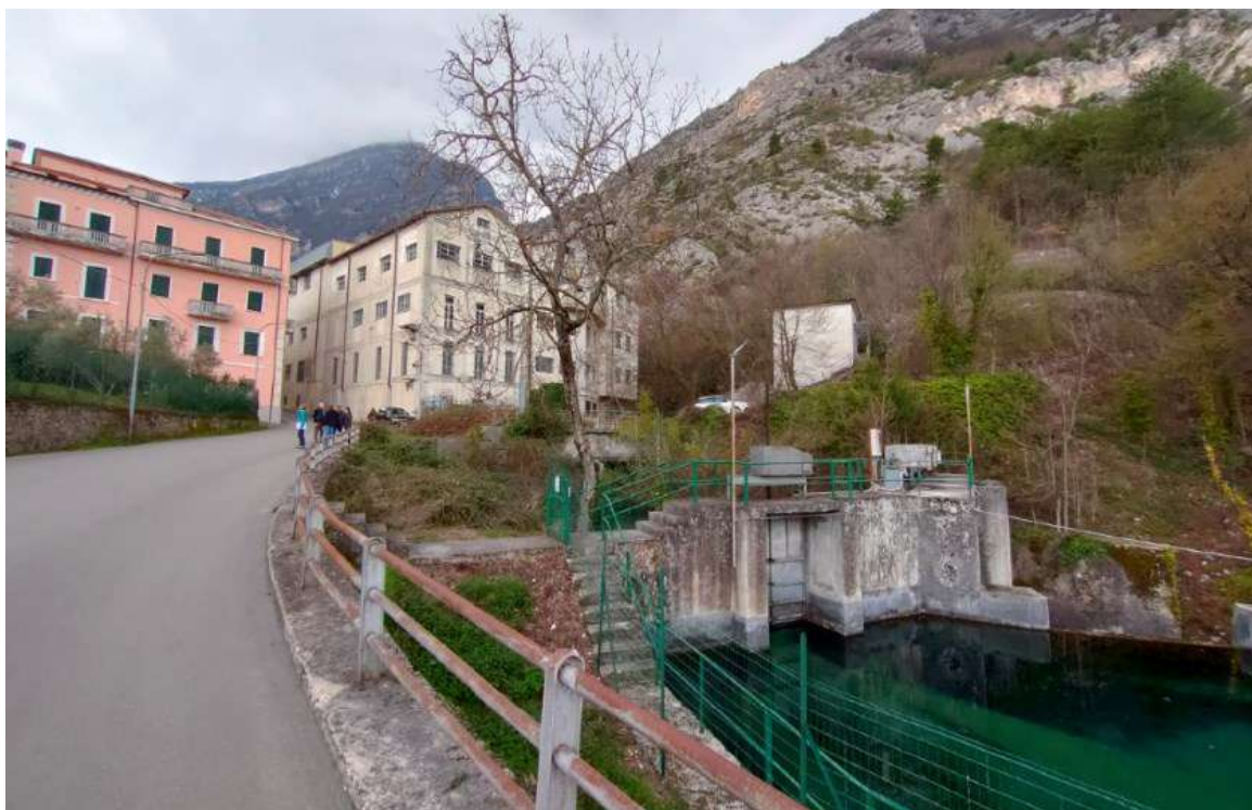
Vista dell'area di partenza della tubazione
