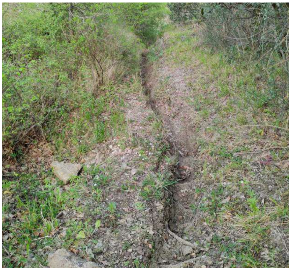
Solchi di erosione nella medesima formazione
