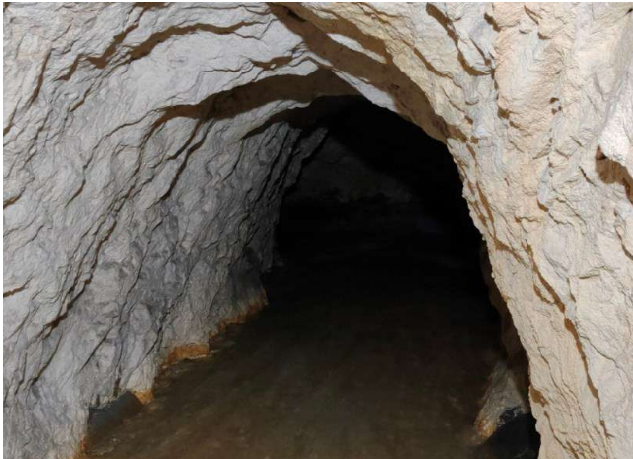
Vista dei calcari all'interno delle gallerie di captazione
