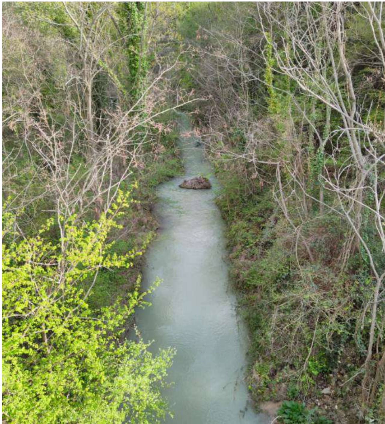
La valle all'uscita dalla diga di Casoli presso il ponte sul F. Aventino su cui passerà la nuova tubazione
