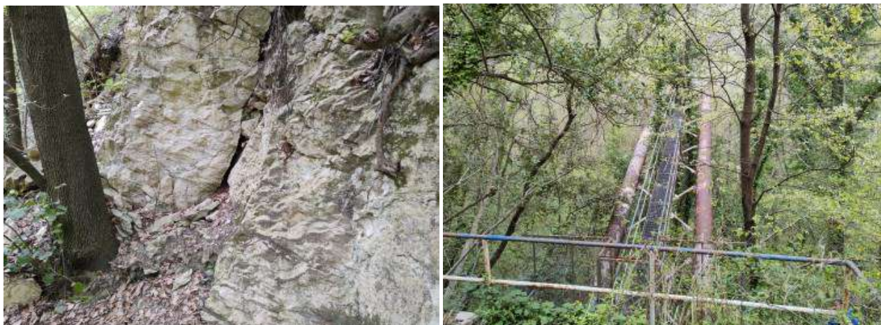
Fondo della valle dell'Aventino; affioramenti e l'attuale opera di attraversamento
