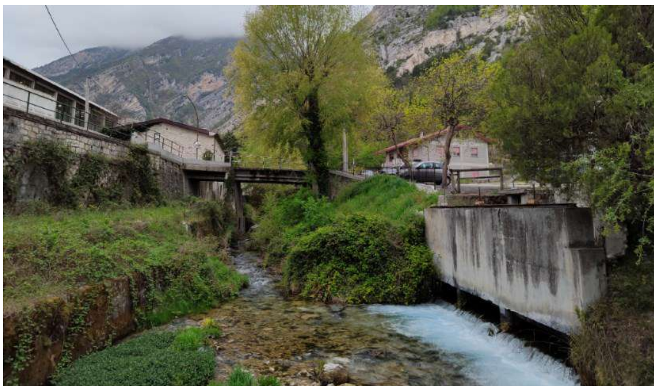
Tratto fra i fabbricati industriali della Del Verde e della De Cecco con le varie opere di presa (a valle della presa acquedottistica)
