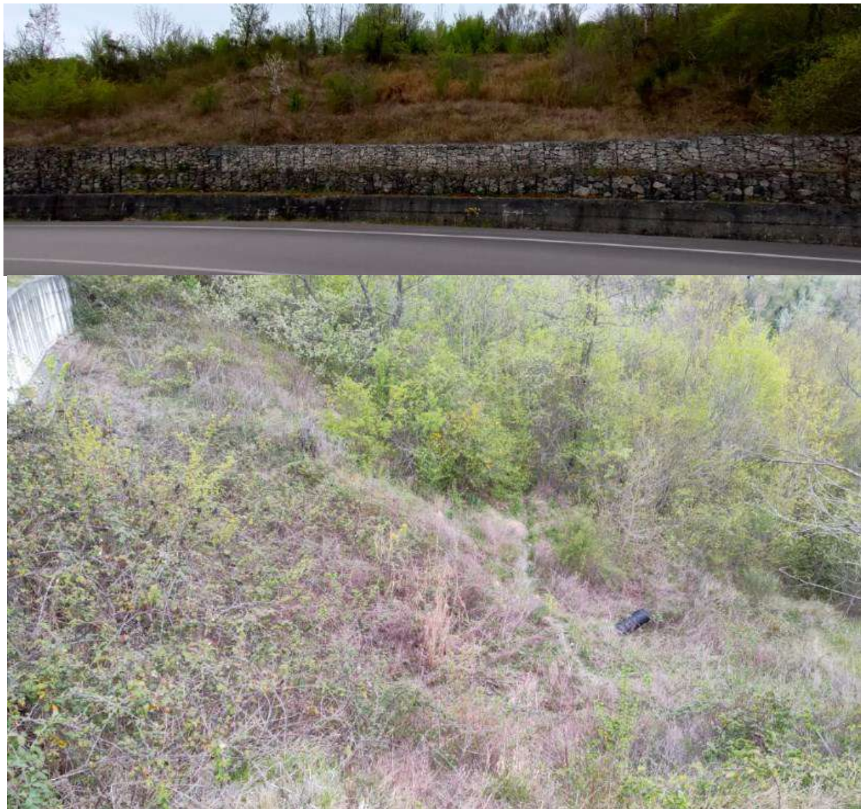
Frana sistemata tramite sostegni a gabbioni e drenaggi nella formazione del Cellino (e sue coltri di alterazione) a monte e a valle della strada provinciale
