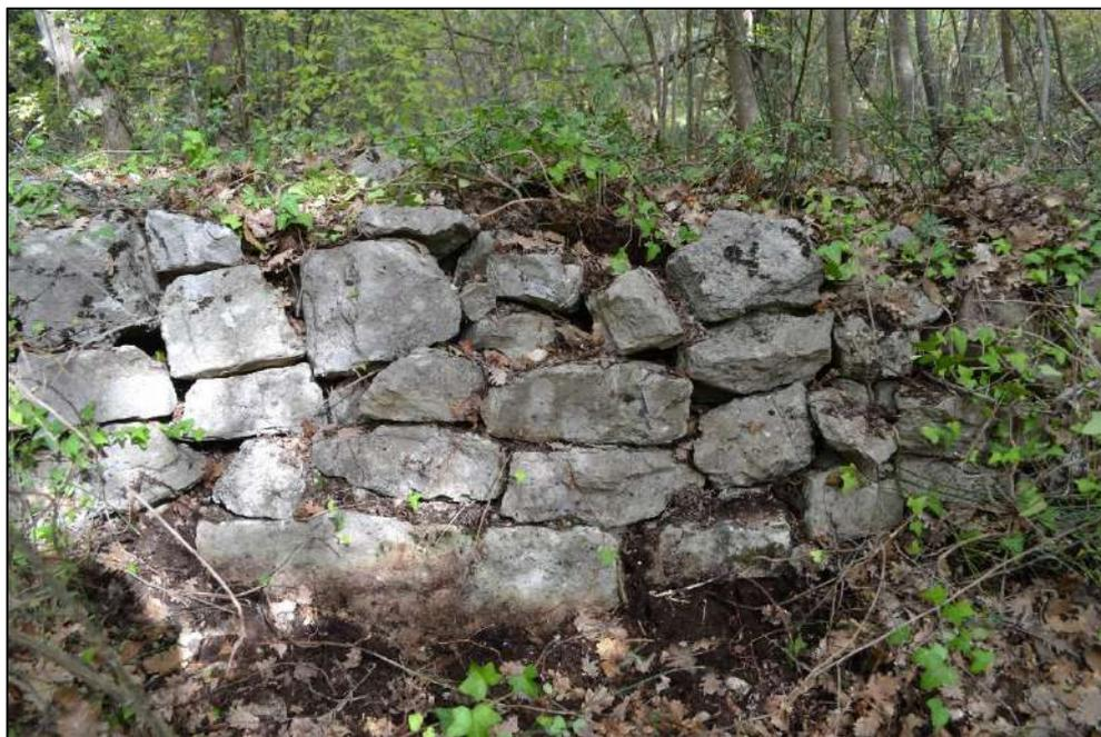
**Figura 32: muro a secco (h. circa 80 cm) individuato nei pressi di un accumulo di pietre**
