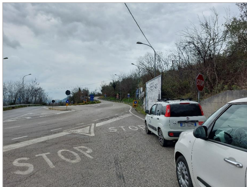
Figura 6 - 20220317_104511: vista dell'area di posa della condotta: attraversamento su SP 214 ex SS 263.
