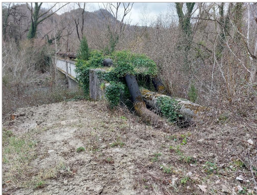
Figura 8 - 20220317_110154: vista dell'attraversamento delle condotte esistenti (non oggetto di intervento) posto a monte dell'intervento.
