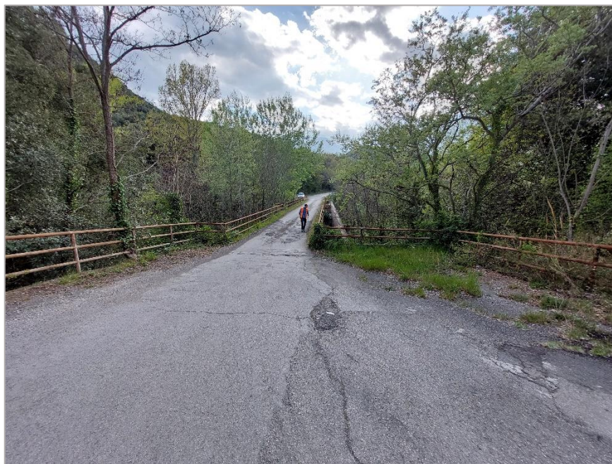
Figura 17 - 20220419_170422: vista della condotta esistente parallela al ponte stradale (non oggetto di intervento).
