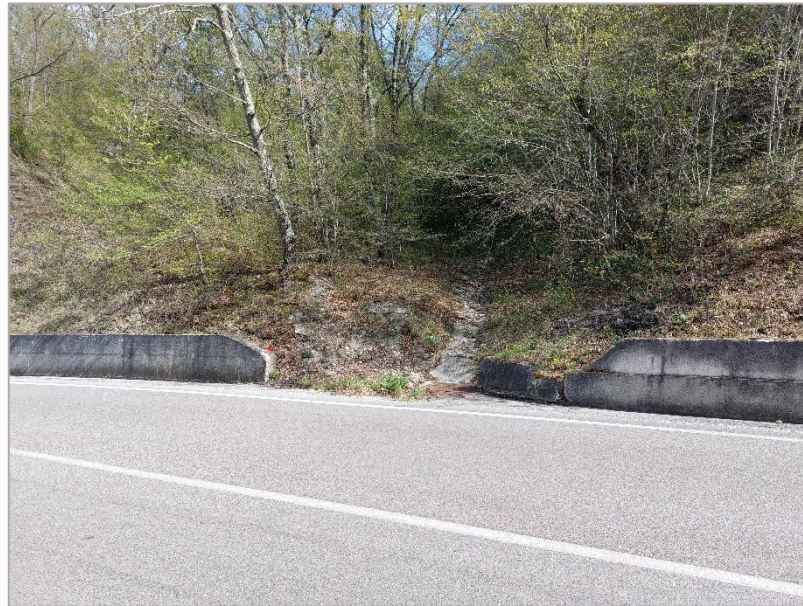
Figura 9 - 20220419_153113: vista dalla SP 95 delle aree boscate che saranno attraversate dalla posa della condotta.
