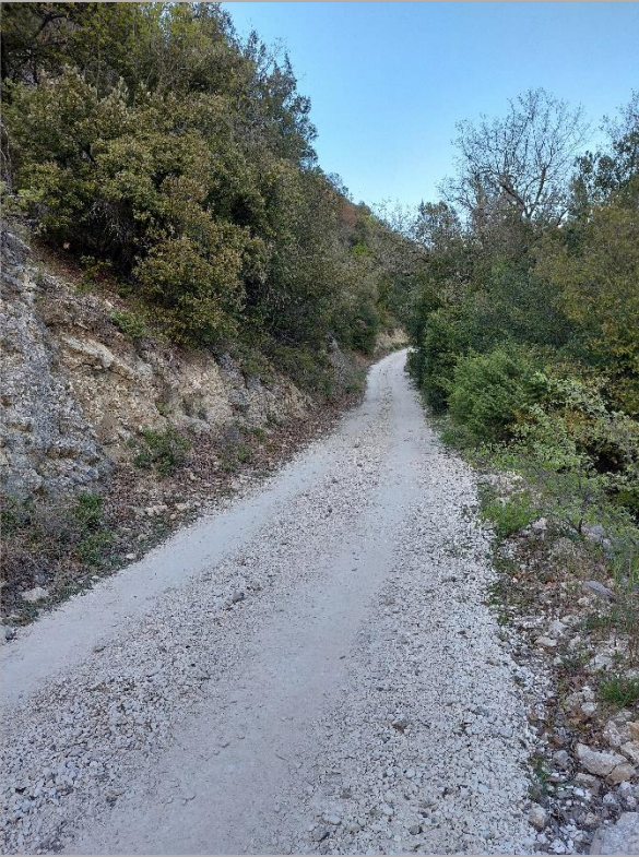
Figura 24 – 20220419_174036: strada sterrata esistente sotto la quale passerà la nuova condotta.
