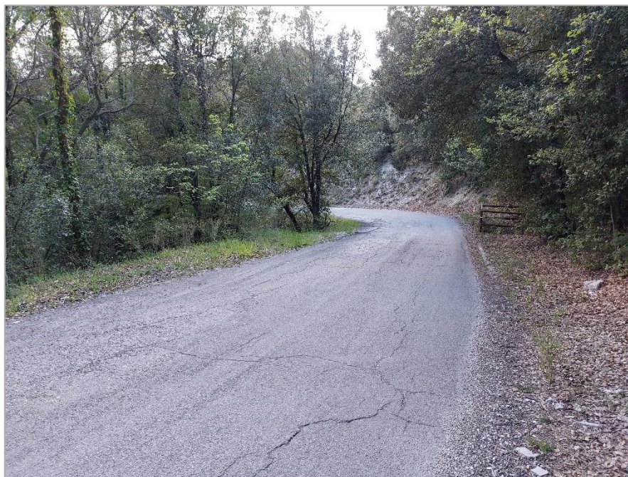
Figura 19 - 20220419_172911: viabilità esistente (Contrada Torretta) sotto la quale passerà la nuova condotta.
