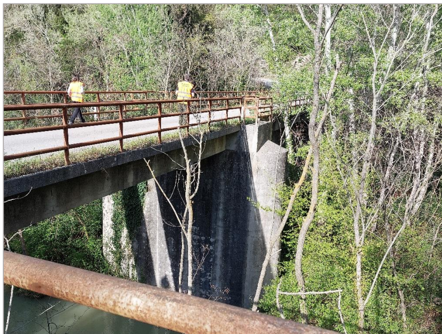
Figura 15 - 20220419_170233: ponte stradale sul fiume Aventino, dove si prevede di realizzare l'attraversamento aereo della condotta di progetto in aderenza alla struttura esistente.
