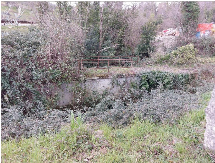
Figura 4 - Attraversamento aereo delle adduttrici esistenti sul canale affluente al torrente Verde.
