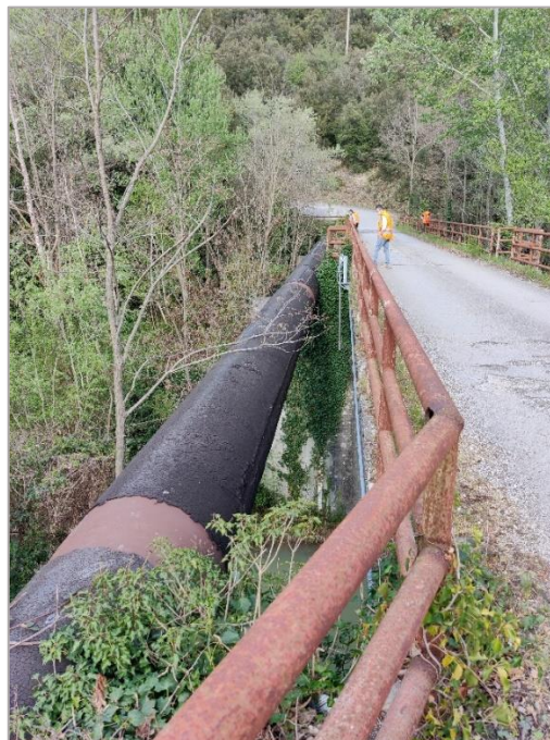
Figura 3 - Ponte sul fiume Aventino e attraversamento dell'adduttrice esistente DN 800 mm.
