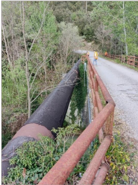
Figura 2 - Ponte sul fiume Aventino e attraversamento dell'adduttrice esistente DN 800 mm.
