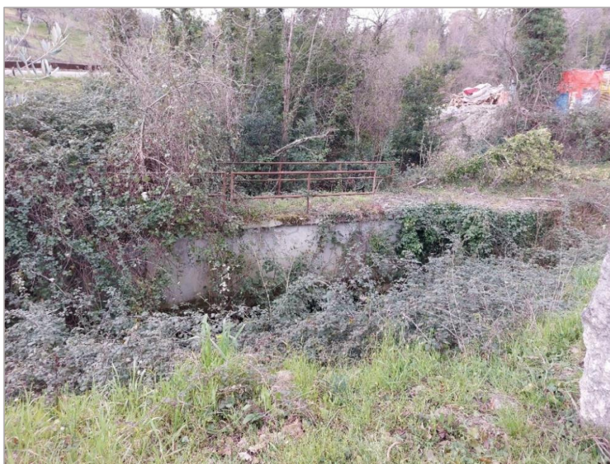
Figura 4 - Attraversamento aereo delle adduttrici esistenti sul canale affluente al torrente Verde.
