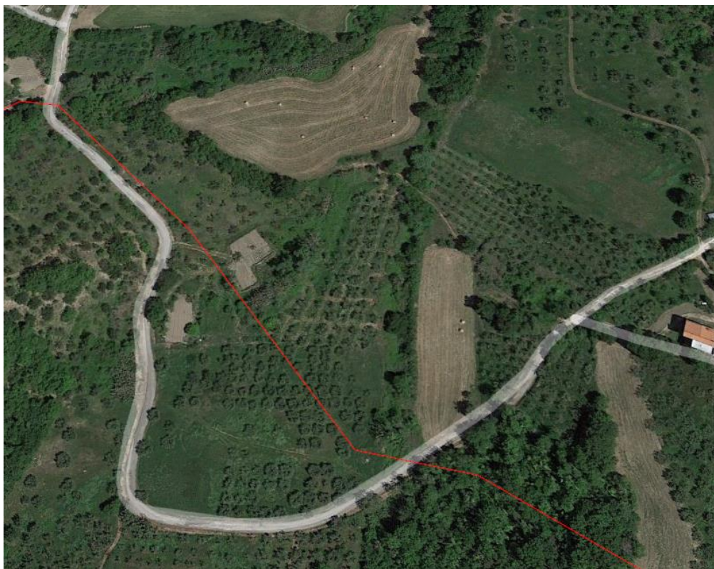
Figura 11 Casali, terreni agricoli. Nessuna anomalia visibile
