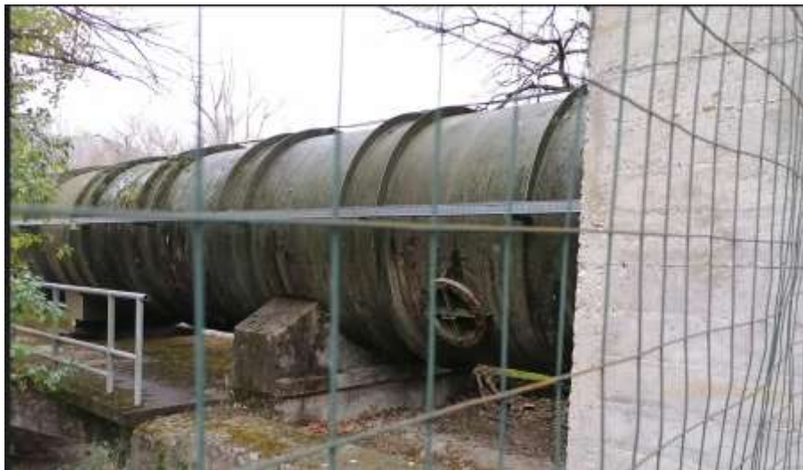
Figura 18: presa diretta dalla condotta di adduzione
