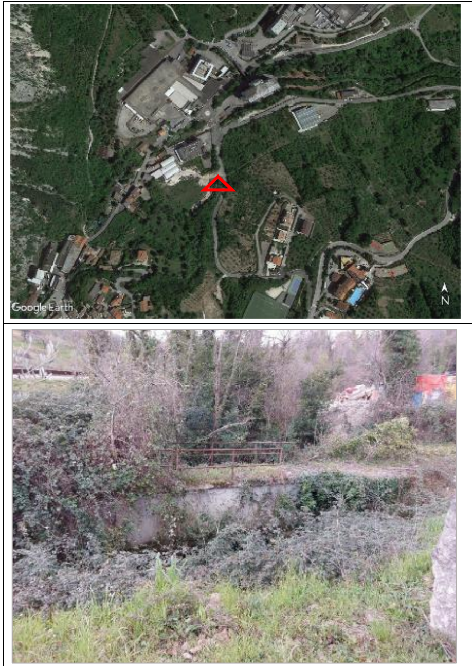
Figura 1 - Attraversamento aereo delle adduttrici esistenti sul canale affluente al torrente Verde.
