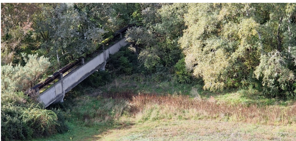
Figura 24 – Attraversamento esistente sul Fiume Oseno.
