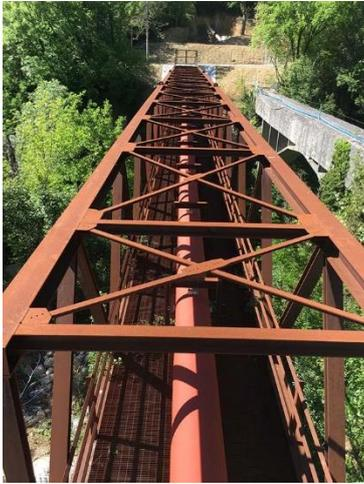
I ponti sono costituiti da una reticolare scatolare in tre casi a campata multipla e in un caso a campata singola di luce variabile, realizzati in acciaio Corten S355.
