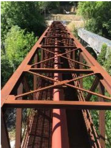
I ponti sono costituiti da una reticolare scatolare in tre casi a campata multipla e in un caso a campata singola di luce variabile, realizzati in acciaio Corten S355. Il progetto prevede l'utilizzo di reticolari scatolari per ridurre quanto più possibile la realizzazione di pile all'interno dei corsi d'acqua e quelle previste sono sempre posizionate in ombra alle pile degli attraversamenti o ponti esistenti.
