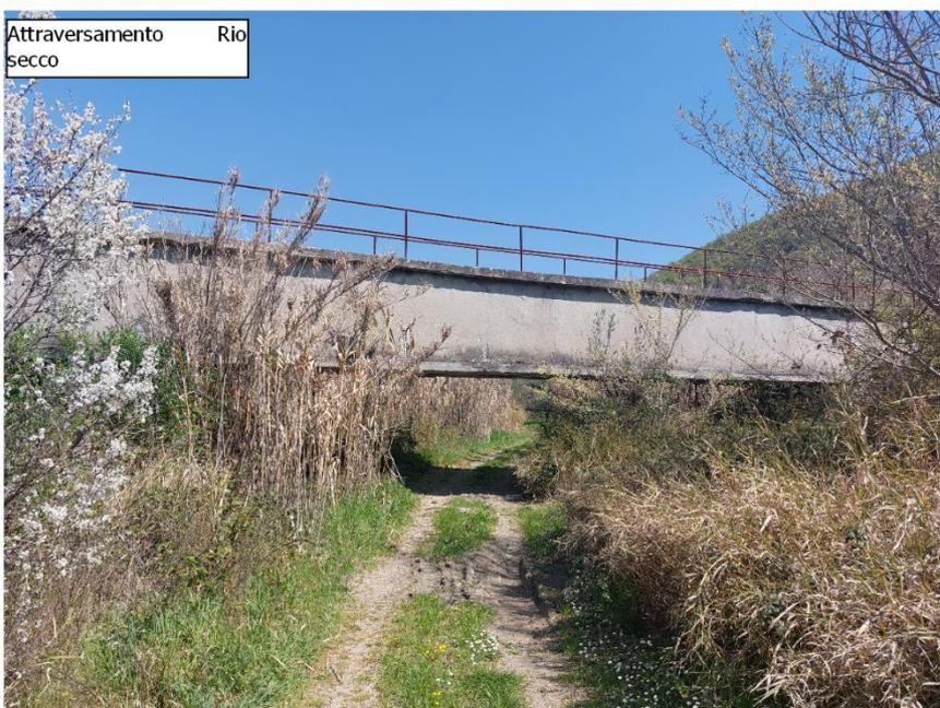
Figura 31 – Attraversamento aereo condotta esistente sul Rio Secco. Attraversamento limitrofo alla condotta di progetto – Stralcio 2.
