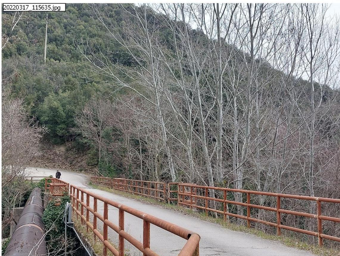
Figura 8 – Vista della condotta esistente parallela al ponte stradale (non oggetto di intervento). La nuova condotta attraverserà il corso d'acqua in appoggio al ponte esistente, sul lato di monte dello stesso - Stralcio 1.
