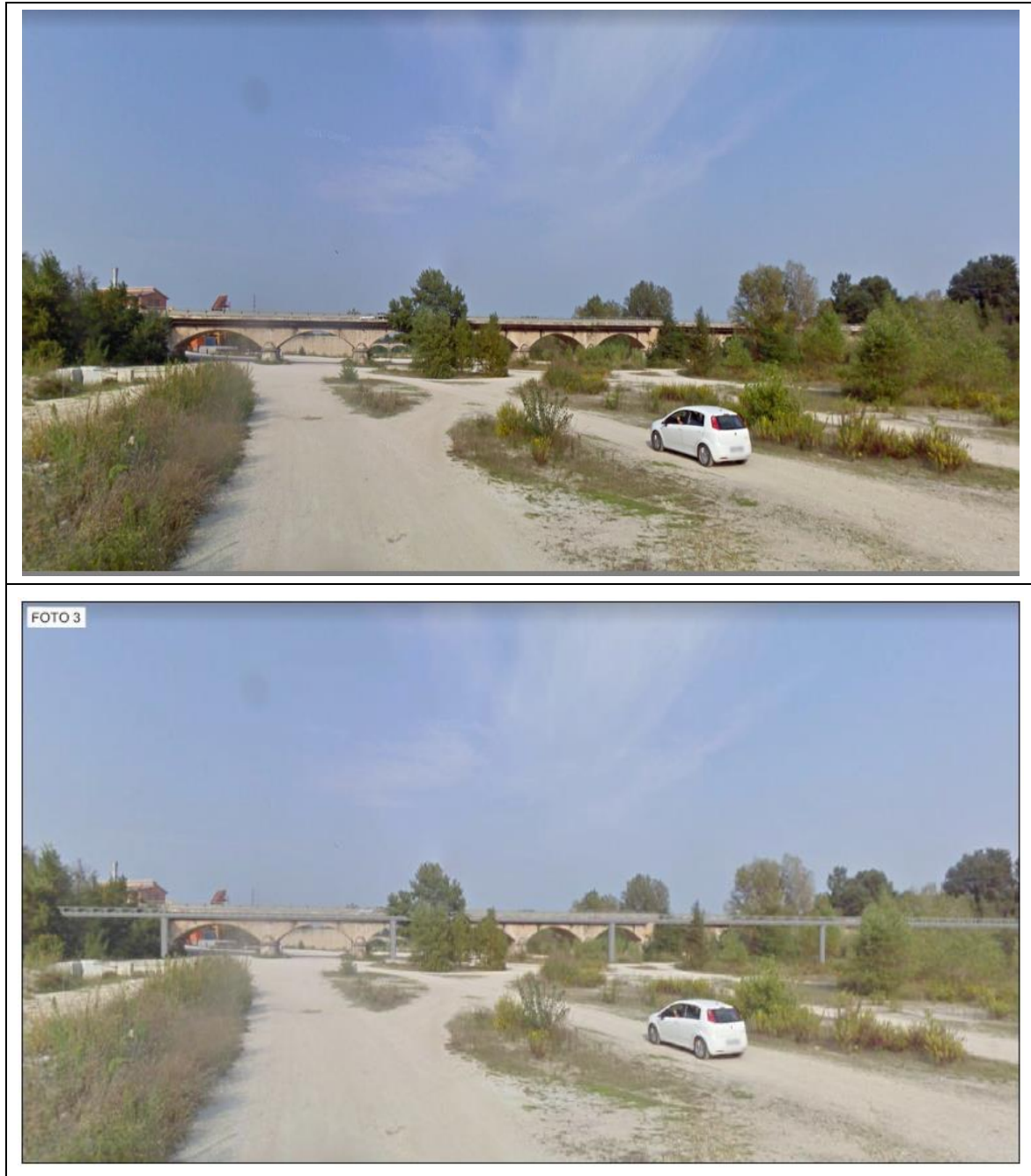
Figura 108 – Rendering dell’attraversamento sul Fiume Sangro (stralcio 2) – visuale 3 (in prossimità del ponte esistente lato nord): stato attuale (sopra) e progetto (sotto)
