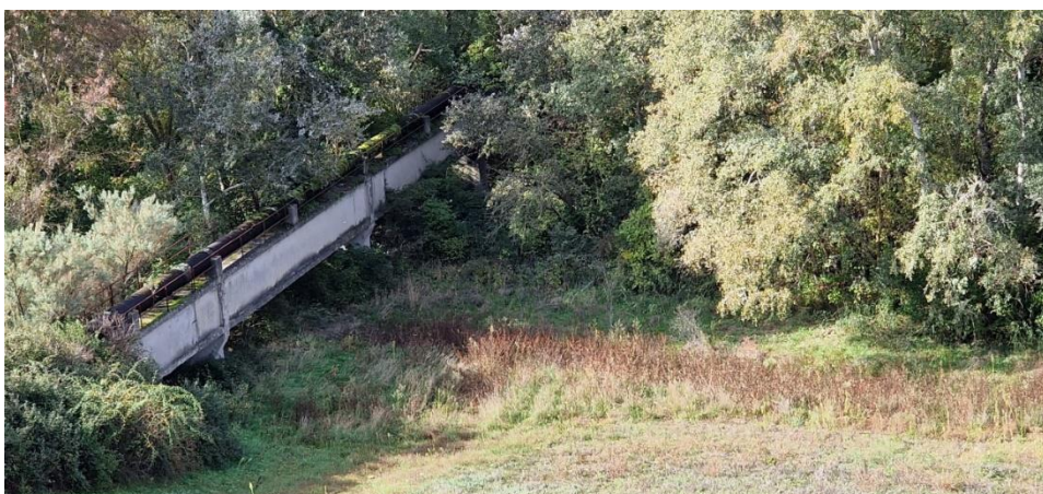
Figura 115 – Attraversamento esistente sul Fiume Oseno.
