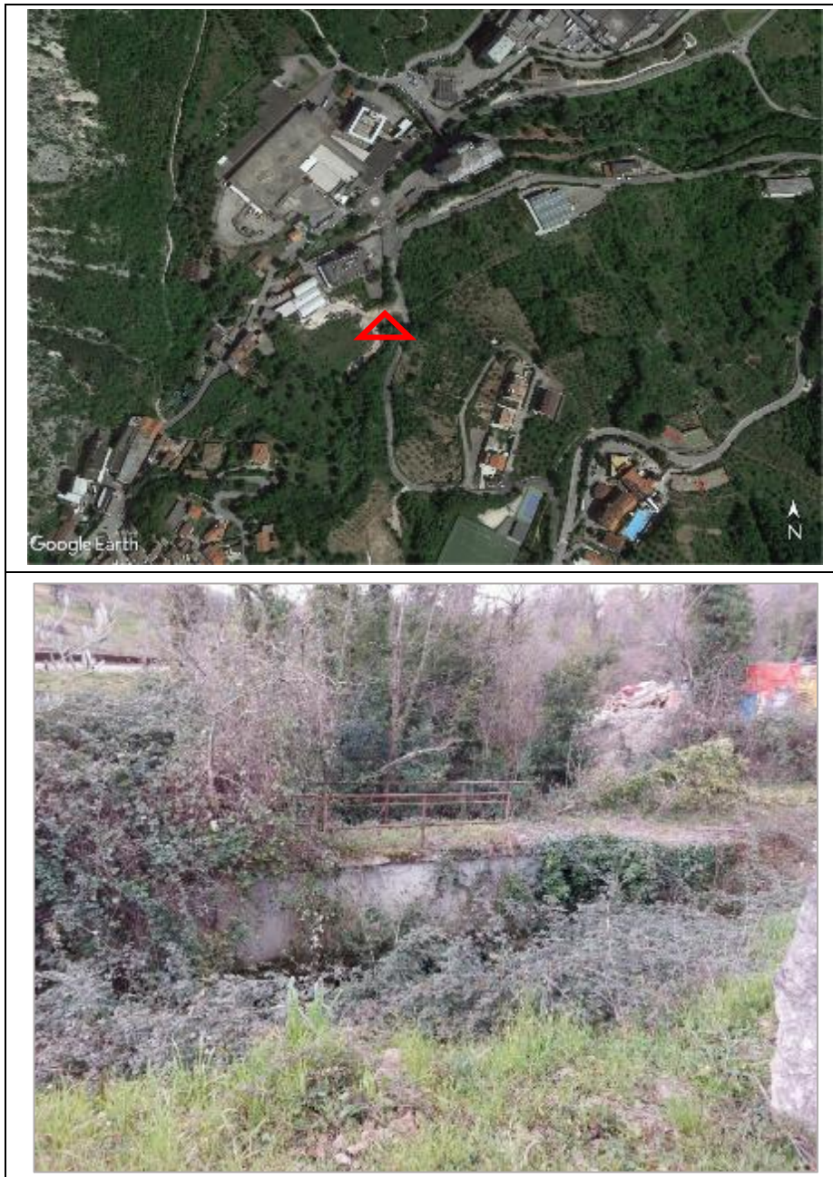
Figura 92 - Attraversamento aereo delle adduttrici esistenti sul canale affluente al torrente Verde.
