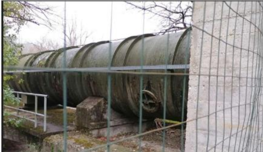
Figura 53: presa diretta dalla condotta di adduzione
