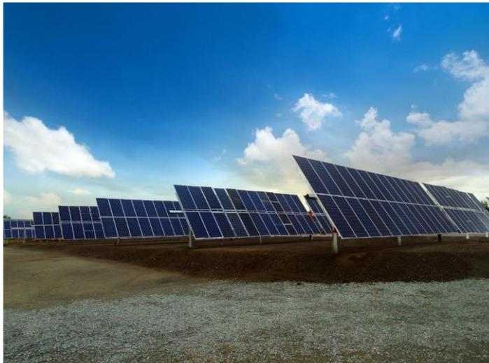
L'impianto fotovoltaico è composto da moduli posti su strutture ad inseguimento solare monoassiale (tracker).
