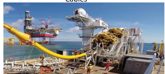
Figura 22 - Particolare dell'imbarcazione posa cavi - NKT Cables
