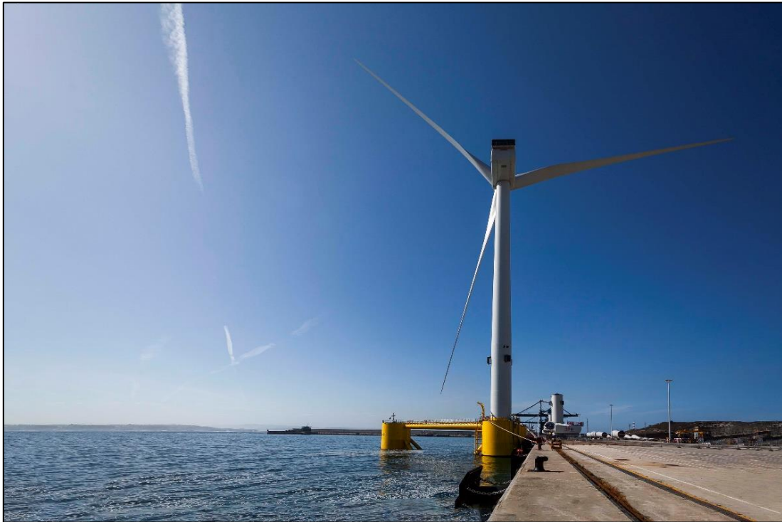
Figura 2-27 – Fasi di assemblaggio della piattaforma galleggiante (Fonte Windfloat Atlantic Project)
