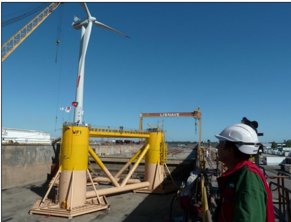
Figura 2-26 – Fasi di assemblaggio della piattaforma galleggiante (Fonte Windfloat Atlantic Project)
