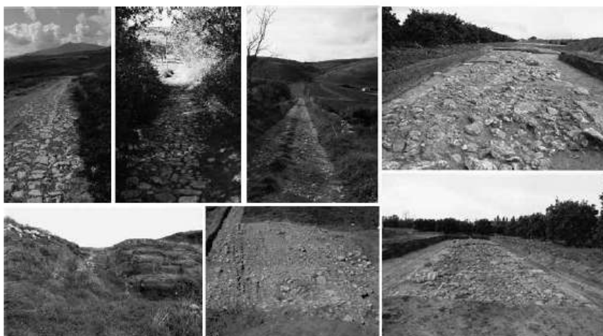
Fig. 13. Tipi di tecnica costruttiva della strada presenti nel comprensorio apulo-lucano
