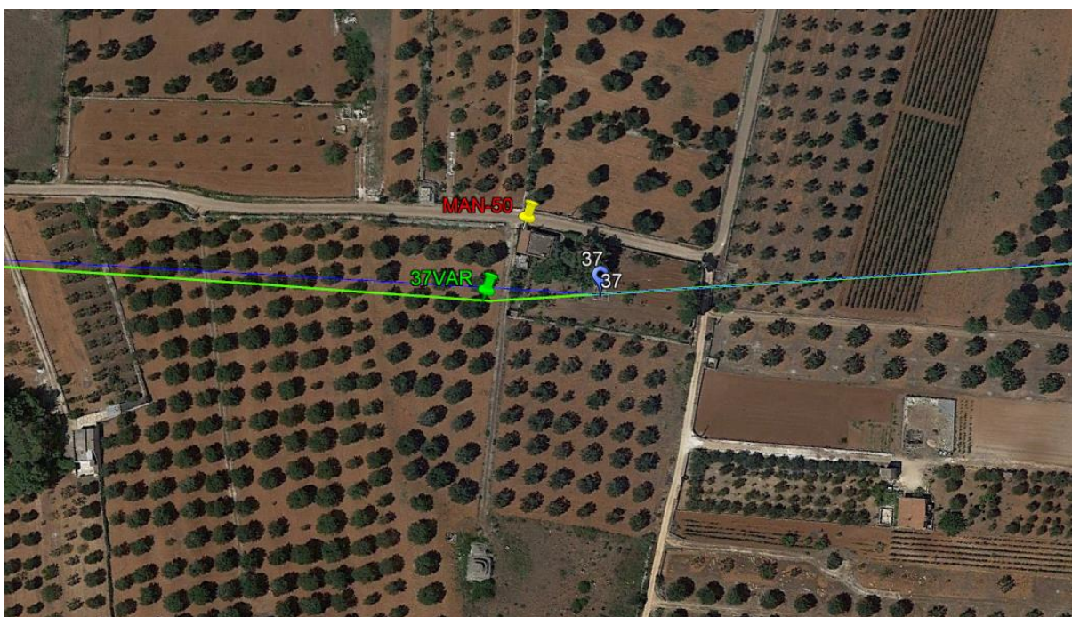
Figura 15: : Dettaglio del sostegno 37VAR
