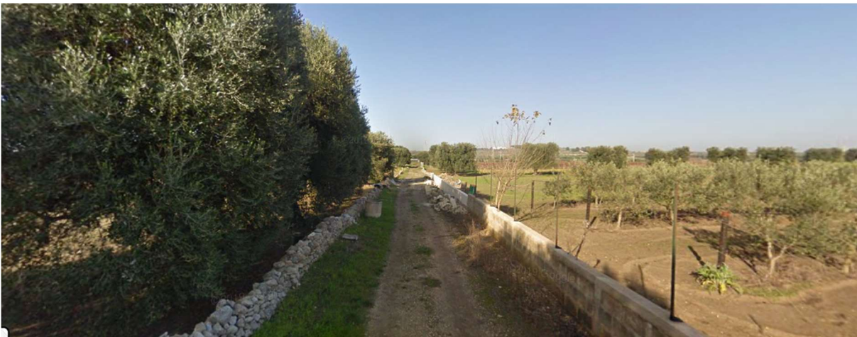
Figura 3-3: Delimitazione a muretti a secco e delimitazioni con muretti di tufo.
