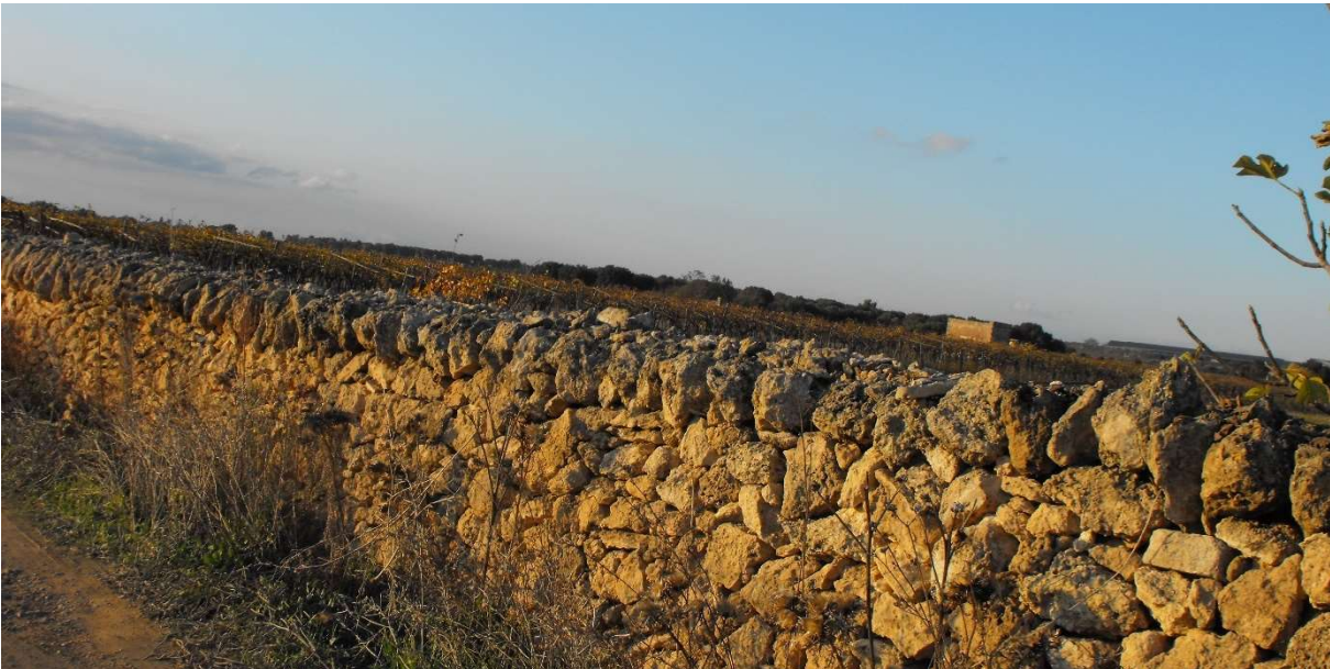
Figura 3-6: Muretto di altezza consistente in buono stato di conservazione ad ovest dell'area
