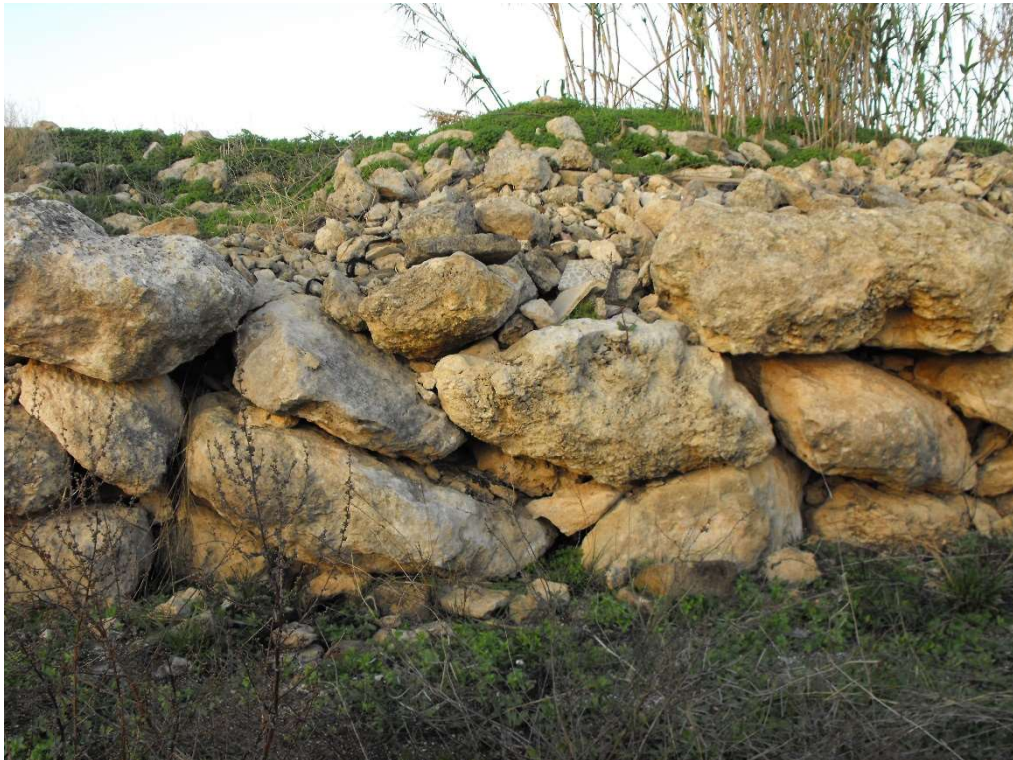
Figura 3-8: Muretto con pietre di grandi dimensioni a nord dell'area
