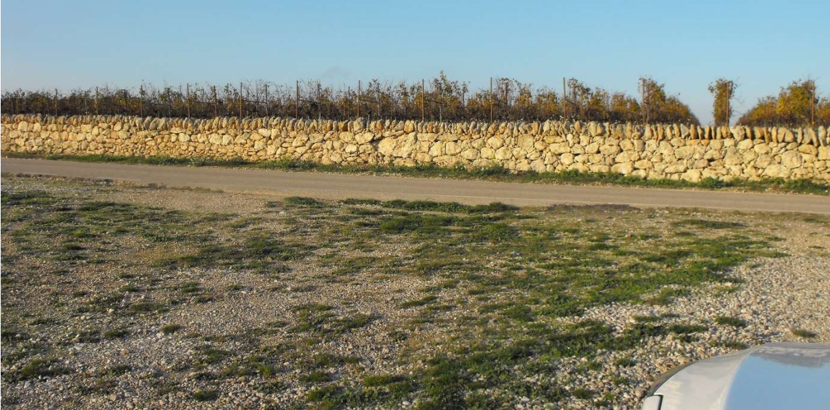
Figura 3-5: Muretto di media altezza in buono stato di conservazione a sud dell'area
