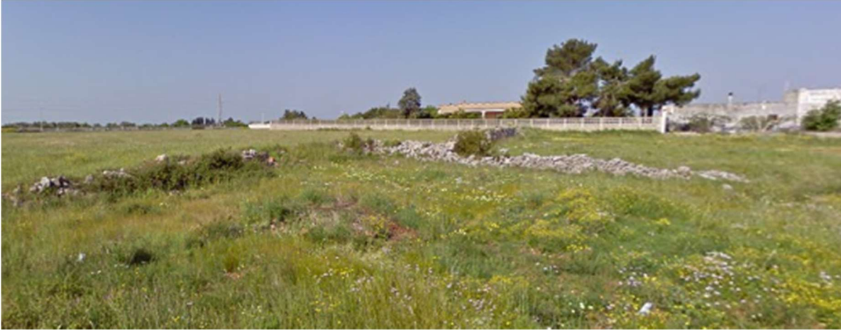
Figura 3-19: Muretto a secco nell'area di buffer del traliccio N4
