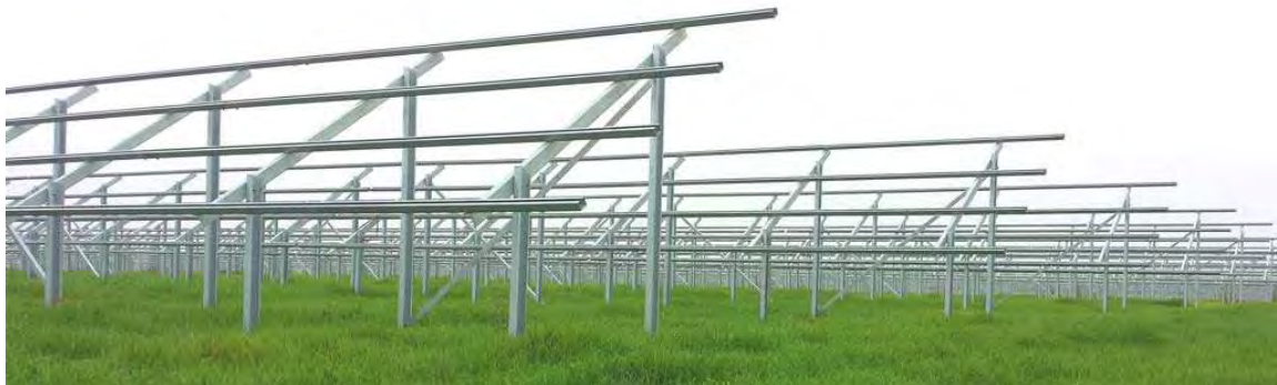
Figura 3.4 – Strutture ad orientamento fisso
