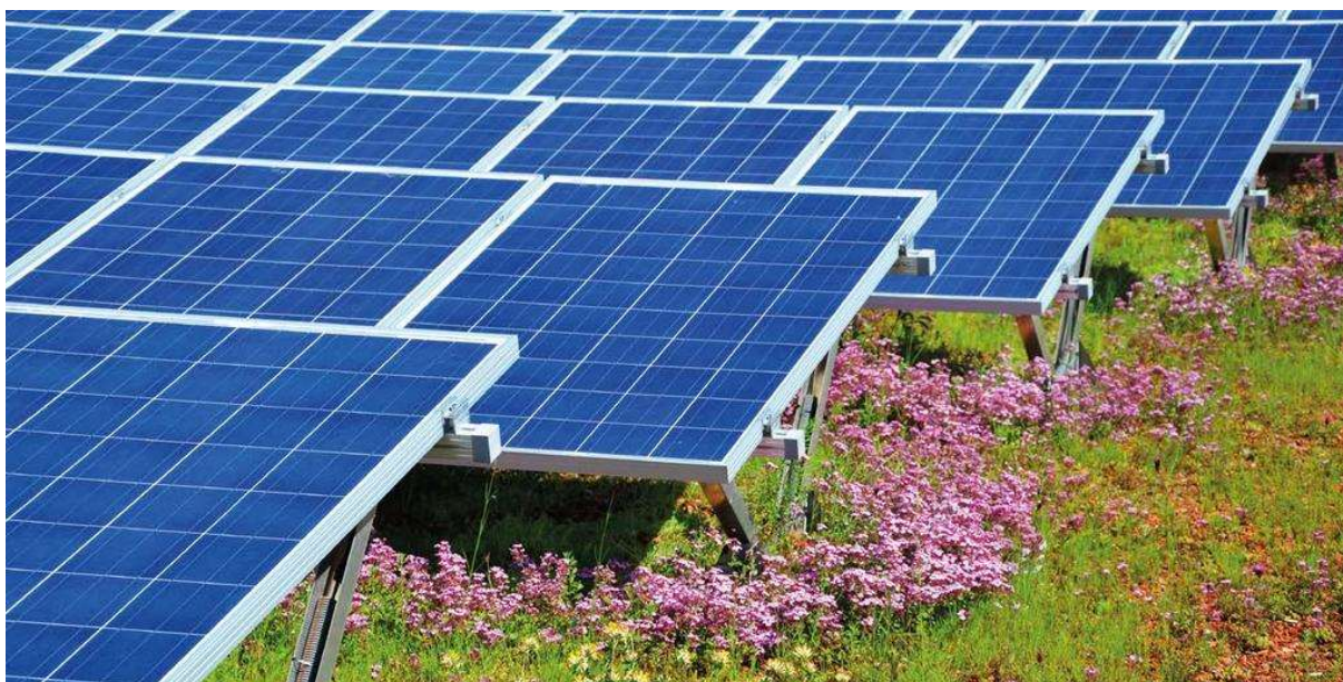
Figura 6.6 – Esempio di rinaturalizzazione al di sotto dei pannelli FV con piante da fiore
