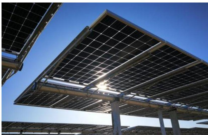
*Figura 2.7 Esempio di struttura a tracker monoassiale*
