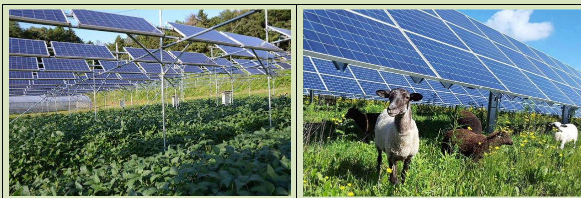
Figura 1.1: Esempi Impianti Agri-voltaici
