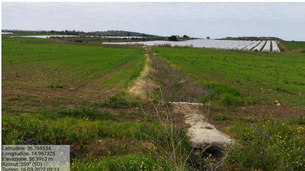
**Figura 11: Canale ed attraversamento in monoblocco cementizio**
