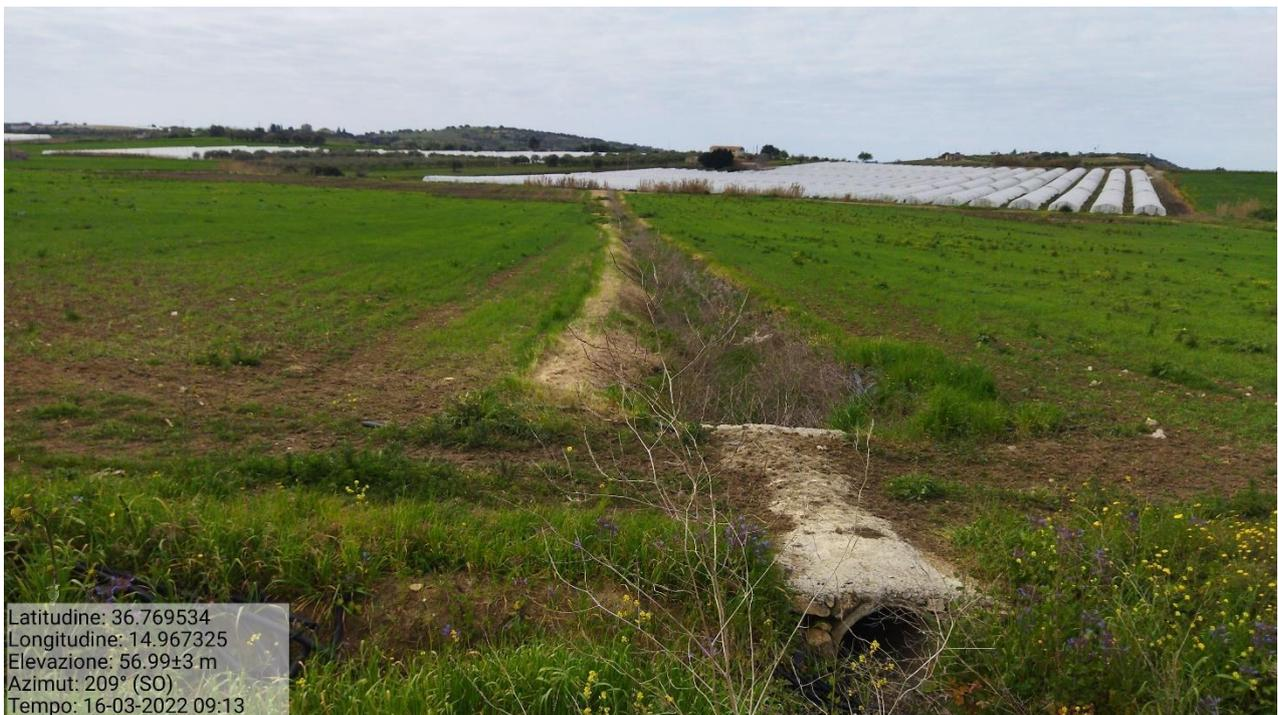
**Figura 9: Canale ed attraversamento in monoblocco cementizio**
