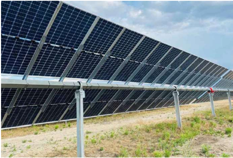
(Esempio di tracker monoassiale montante moduli bifacciali: si scorge in rosso il motore per la rotazione)
