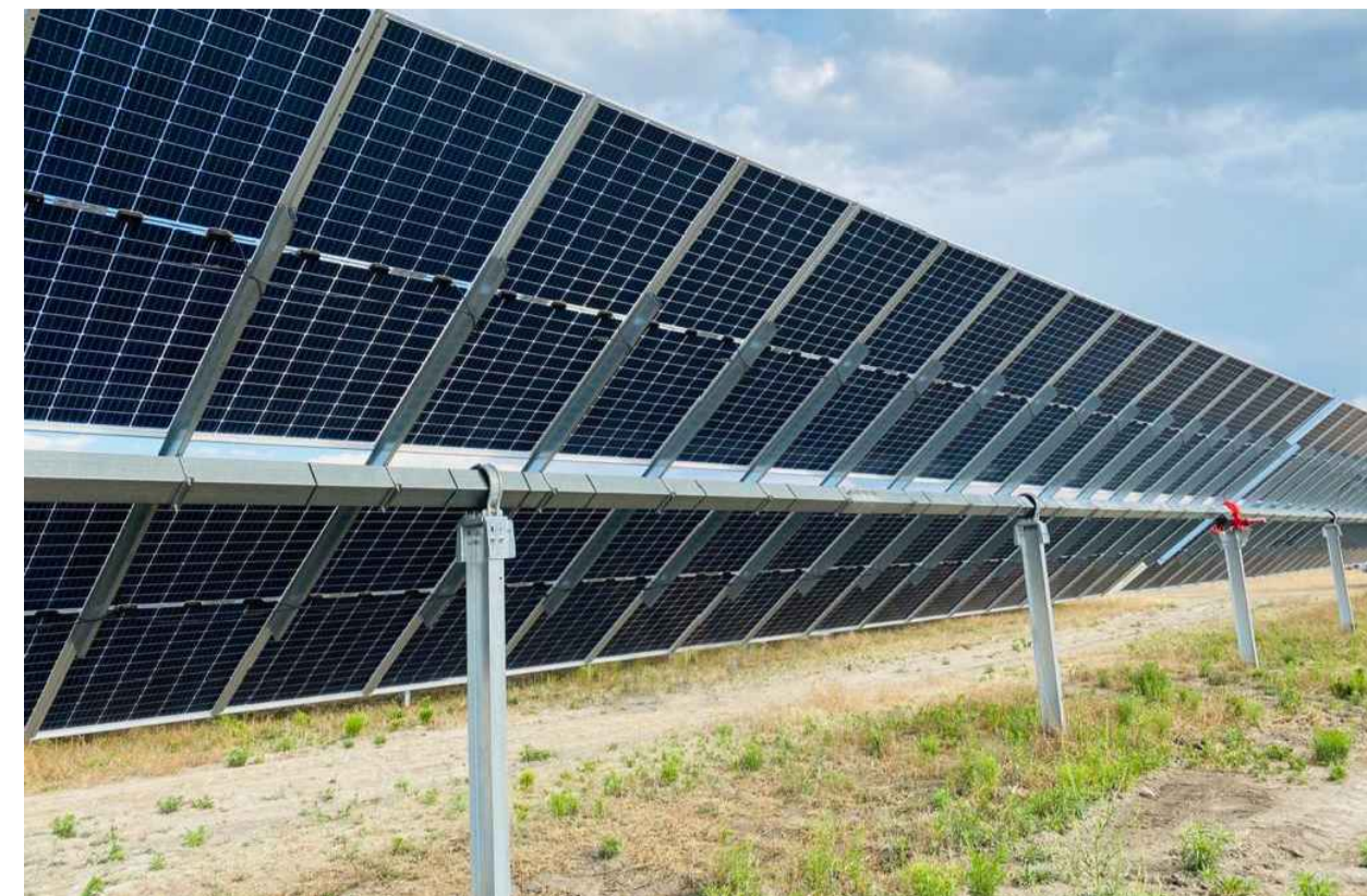
MODULO FOTOVOLTAICO BIFACCIALE ANTIRIFLESSO 660 Wp
