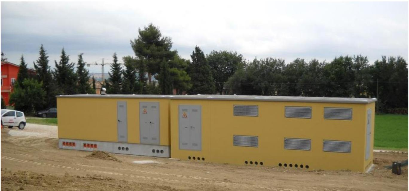
Gli elementi della cabina, prefabbricati in stabilimento, saranno trasportati in cantiere e montati contemporaneamente alla fase di scarico.
