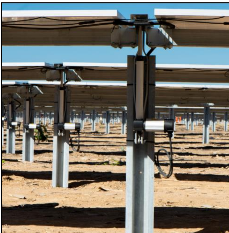
Figura 25-Rappresentazione della struttura di supporto vista posteriore
