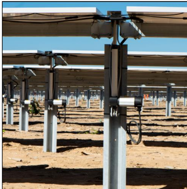
Figura 13- rappresentazione della struttura di supporto - vista posteriore
