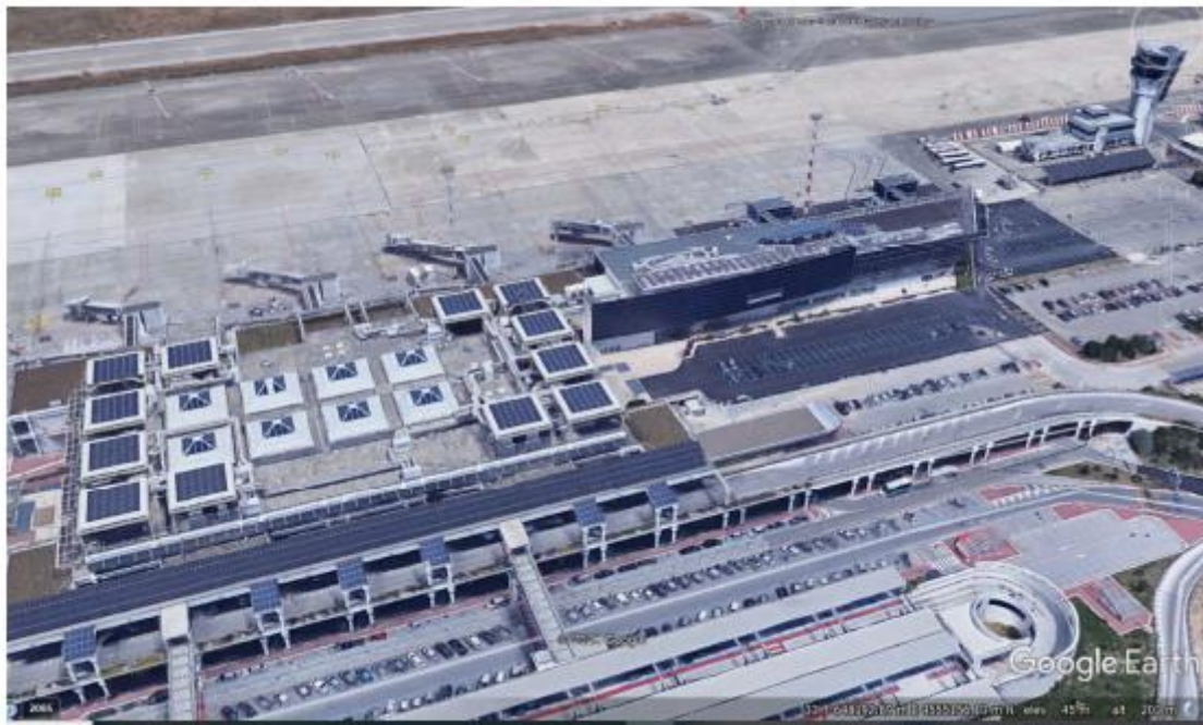
Figura 36 – Esempio di un fotovoltaico installato all'interno di un aeroporto
