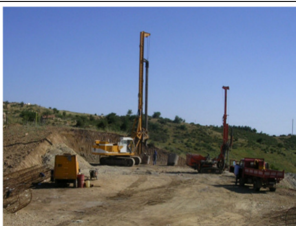
Realizzazione pali trivellati
