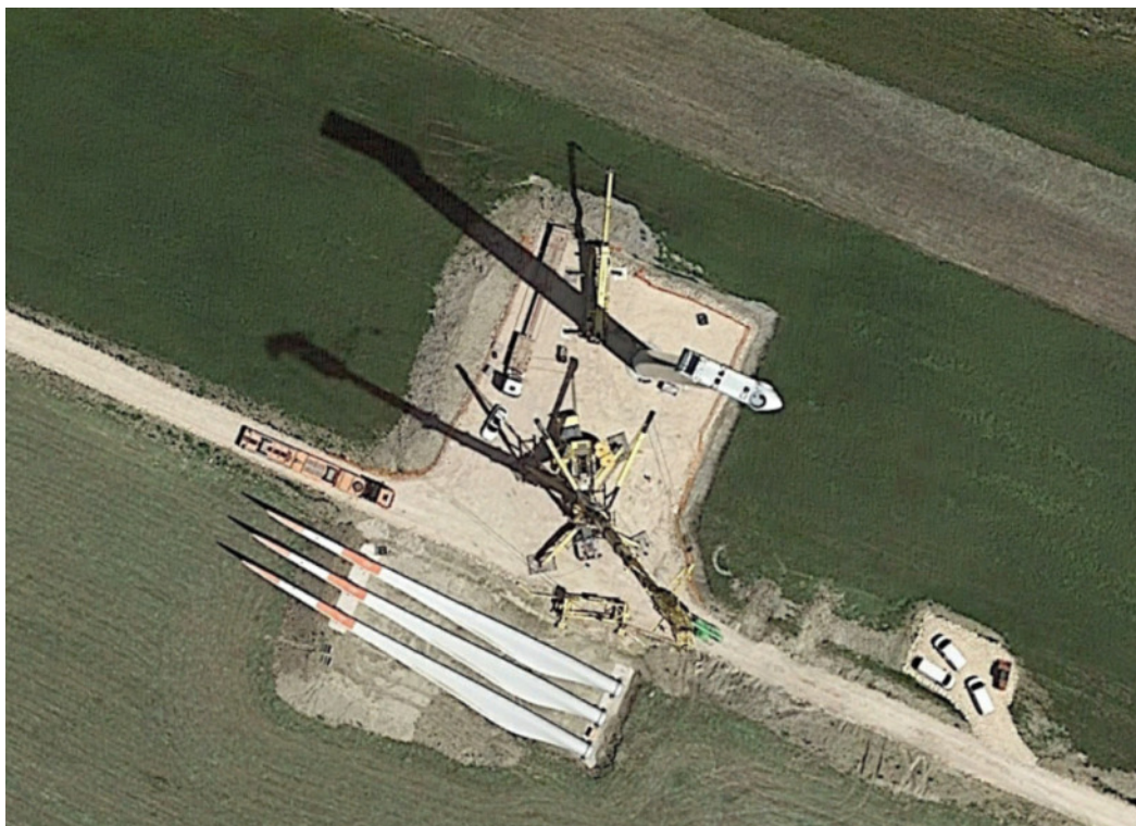
Figura 3.4 – esempio di piazzola in fase di costruzione
