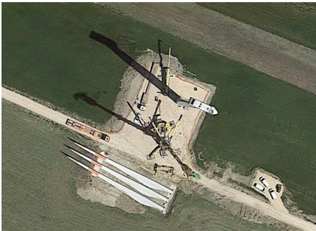
Figura 3.6: Esempio di piazzola in fase di costruzione
