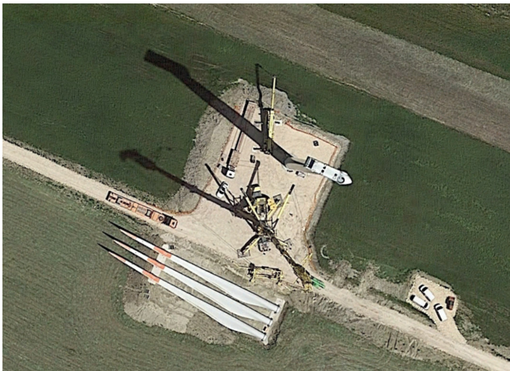
Figura 5.6: Esempio di piazzola in fase di costruzione
