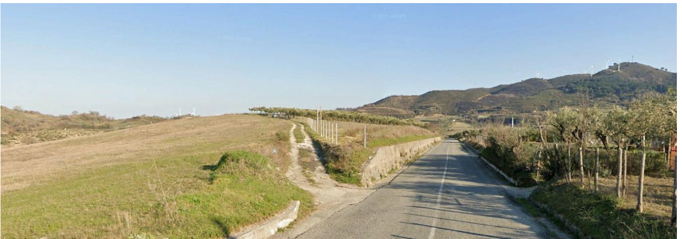
Figura 4-5: Viabilità di accesso alla WTG04
