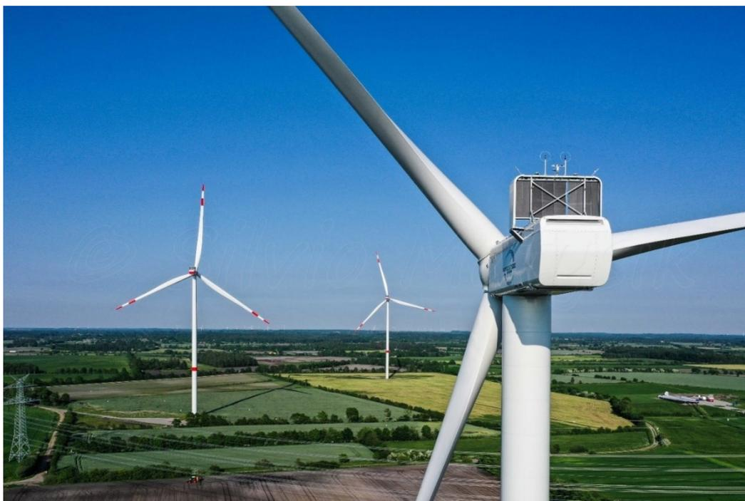
Figura 4.7: Aerogeneratori con segnalazione diurna realizzata mediante la colorazione delle pale (fonte: <https://it.wind-turbine-models.com/turbines/1839-vestas-v136-4.2?picture=wVz1tQ3phn2#pictures>)
