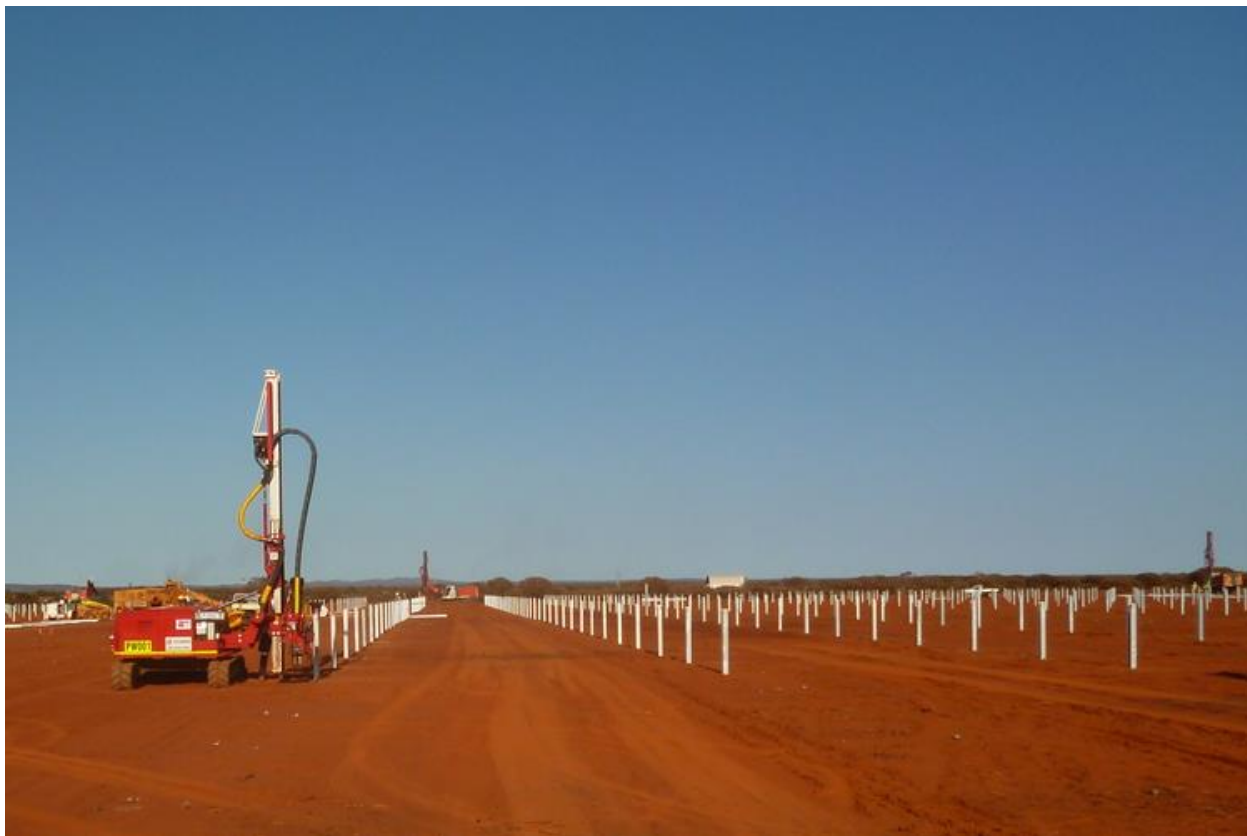
Figura 56: Dettaglio posizionamento pali
