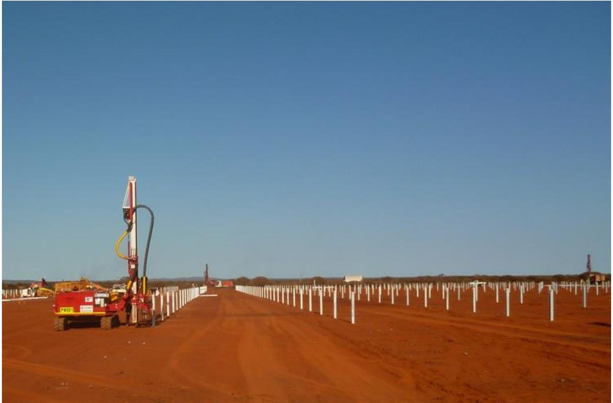
**Figura 31: Dettaglio posizionamento pali**
