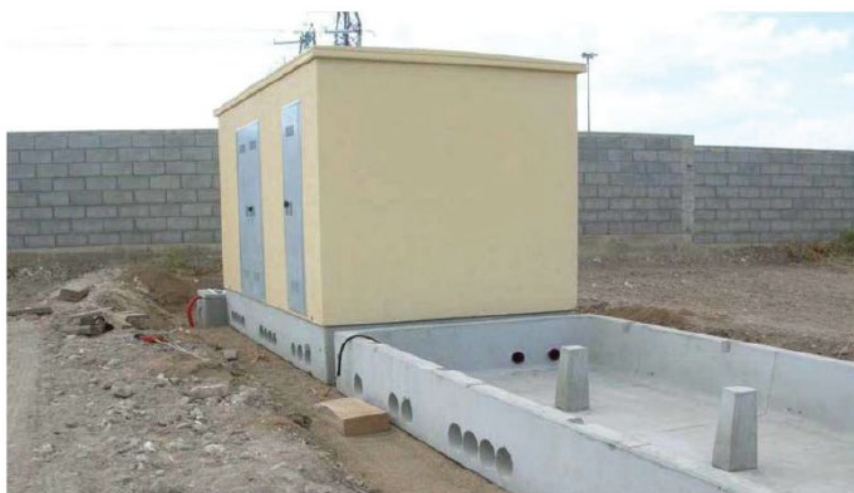
Figura 3 –Struttura di fondazione prefabbricata delle cabine elettriche.
