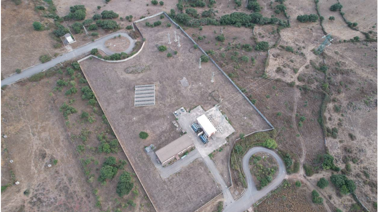
Fotografia 13 : Vista aerea della cabina CP di Suni dove è previsto l'allaccio
